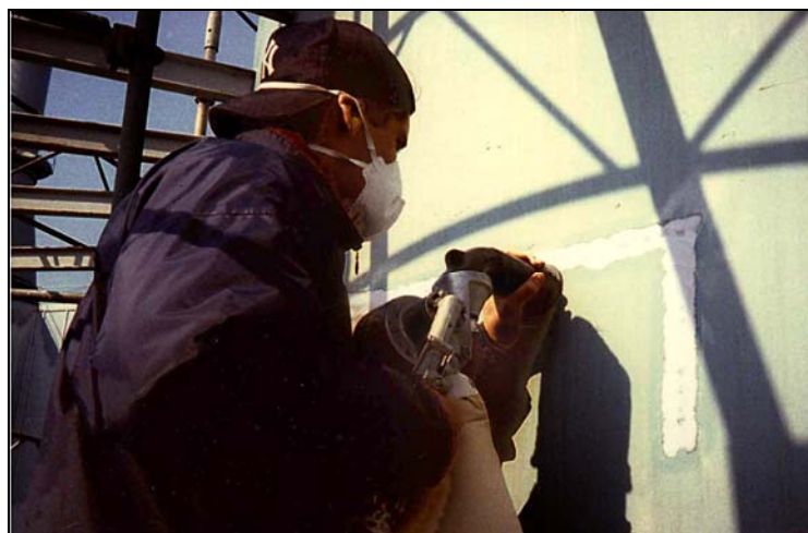
Bortblästring och provtagning av färg enligt RUT-metoden. (Provtagning ca 1 m 2 )
