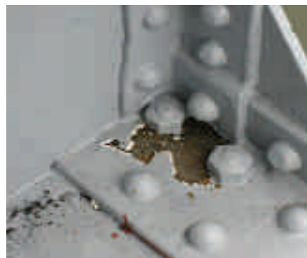
Resultatet av ett för tjockt färglager.
